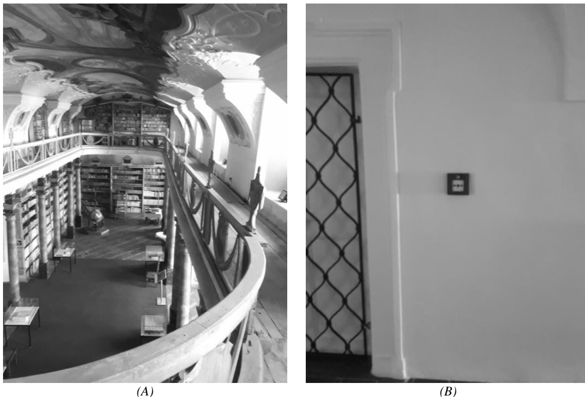
Obr. 2 (A) pohled na prostor klášterní knihovny z ochozu; (B) tlačítkový hlásič u vchodu do knihovny Fig. 2 (A) view of the monastery area from gallery; (B) a button detector at the entrance to the library
